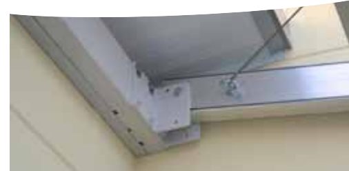
Befestigung mittels Stahlkonsolen direkt am Gebäude
